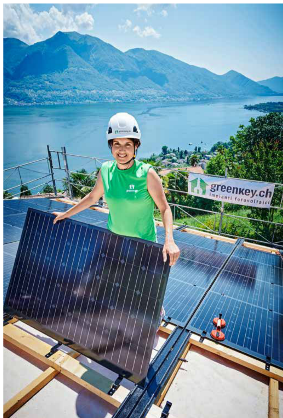
Attiva nel settore da 12 anni: Kim Bernasconi-Nagel mentre lavora a un impianto solare a Brione TI.
